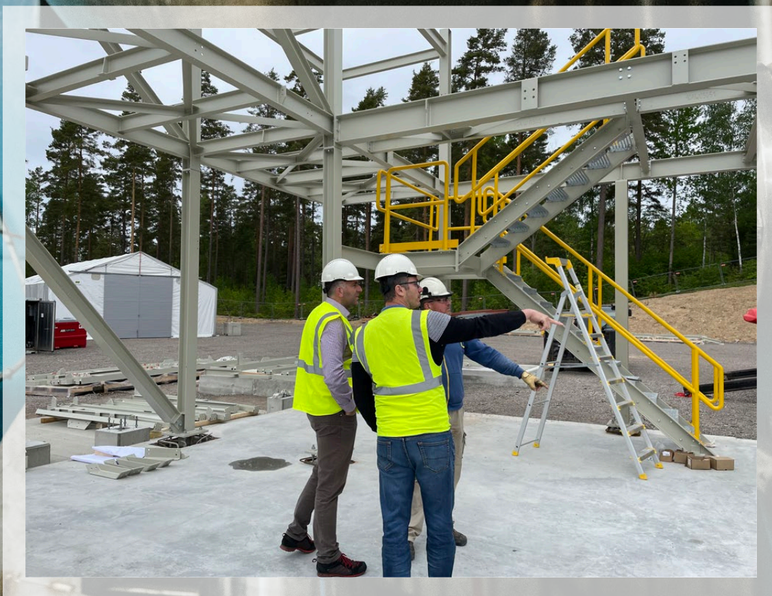
Bild från uppförandet av Meva Energys anläggning hos Sofidel i Kisa.
