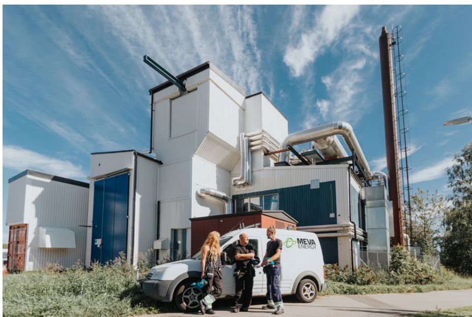
Meva Energys fullskaliga CHP-anläggning i Hortlax med en kapacitet på 1,2 MW el och 2,4 MW värme
