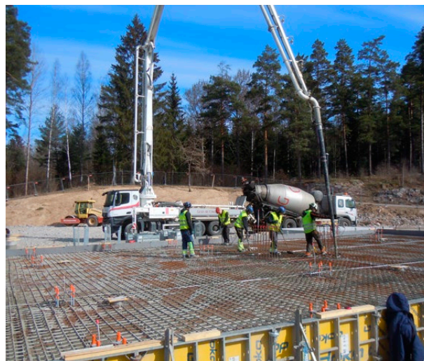
Gjutning av platta för anläggningen hos Sofidel
